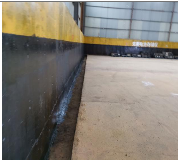
仓储四周导流沟
