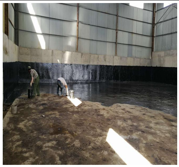
项目仓储区场地施工期防渗建设
