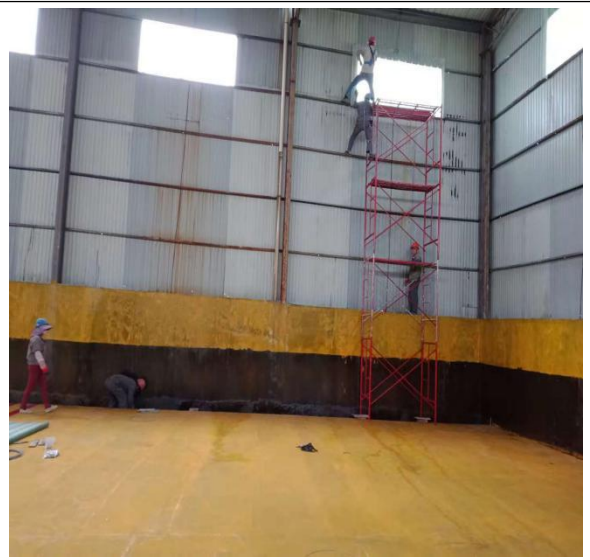
项目仓储区对窗户进行封闭施工过程
