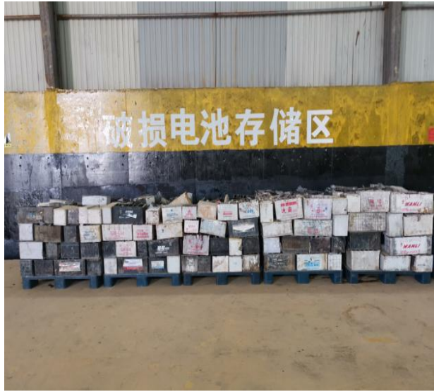
仓储内破损电池储存区
