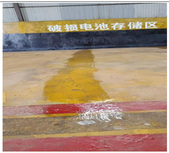
验收监测期间，对有裂纹（破损）地面进行修复
