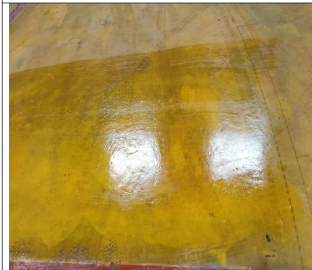
验收监测期间，对有裂纹（破损）地面进行修复
